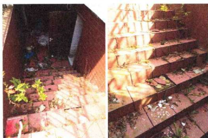
Widok piwnic w parterowym pawilonie wczasowym
