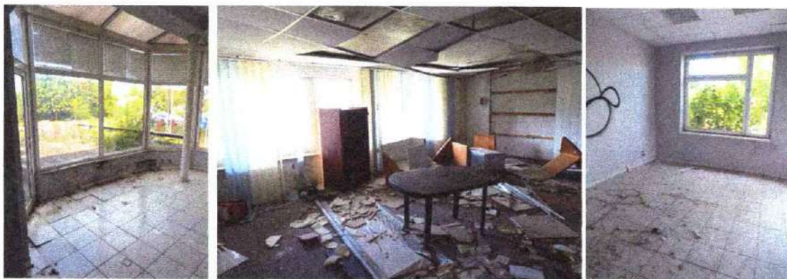
Widok pomieszczeń zaplecza biurowego w części frontowej (od ulicy) w parterowym pawilonie czasowym
