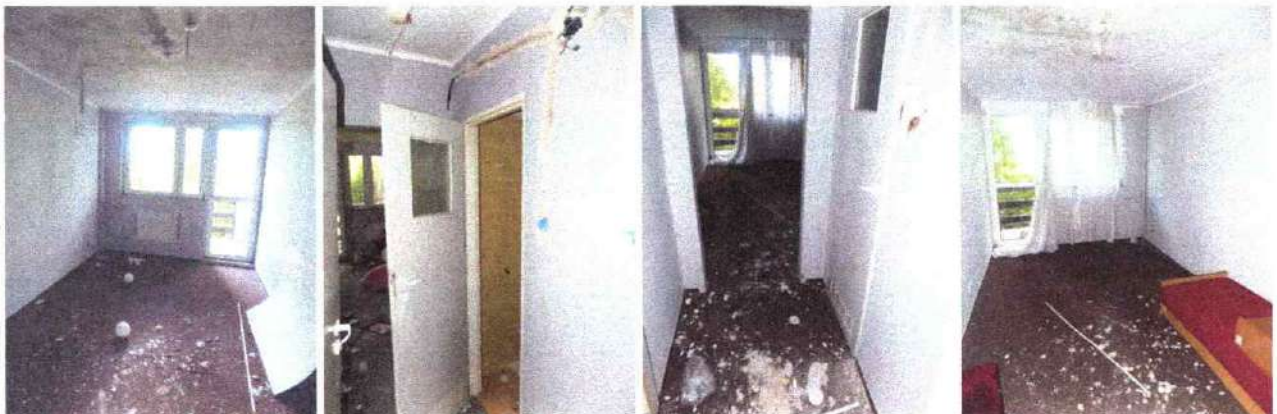
Widok apartamentów wczasowych (pokoi z przedpokojem i niezależną łazienką , część 2 pokojowych) na parterze pawilonu wczasowego 3 kondygnacyjnego
