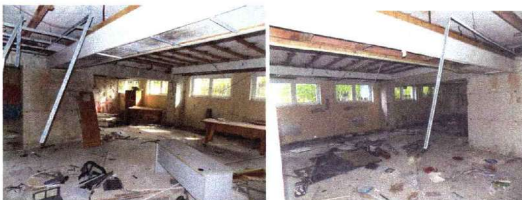
Widok dawnej stołówki w podpiwniczeniu pawilonu wczasowego 3 kondygnacyjnego
