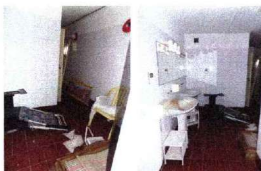
Widok węzła sanitarnego oraz schowka przy węźle na II piętrze (3 kondygnacji) pawilonu czasowego 3 kondygnacyjnego
