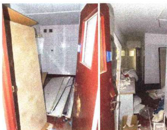
Widok węzła sanitarnego oraz schowka przy węźle na I piętrze (2 kondygnacji) pawilonu wczasowego 3 kondygnacyjnego
