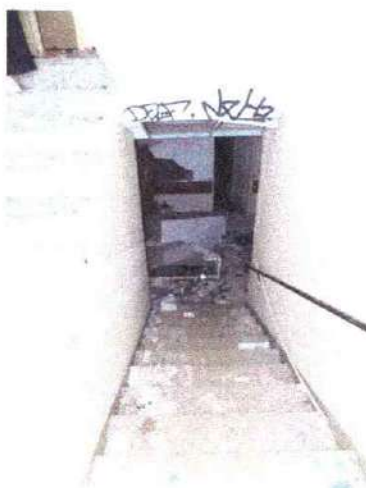
Widok komunikacji w podpiwniczeniu pawilonu wczasowego 3 kondygnacyjnego
